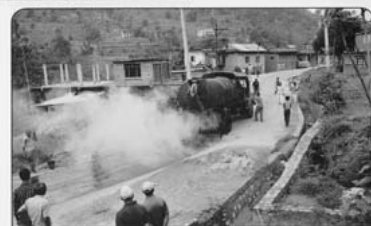
メラムチ・アクセスロード工事
